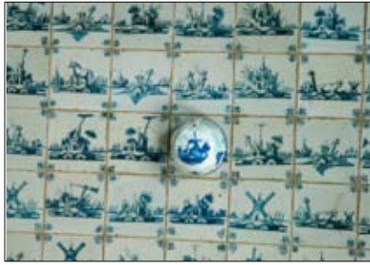
Bezprzewodowa czujka SSP wkomponowana w tło mozaiki w Pałacu w Nieborowie
