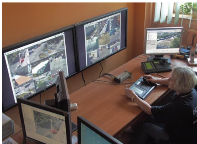
Centrum radiowego monitoringu wizyjnego w Głogowie
